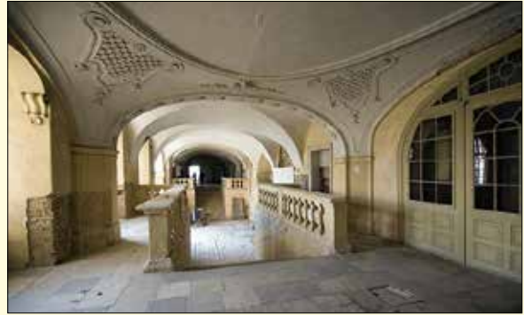
Obnovované interiéry kaštieľa
