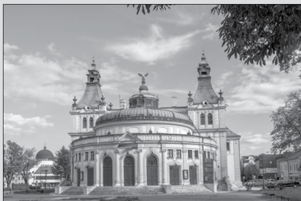
Secesná budova Reduty
