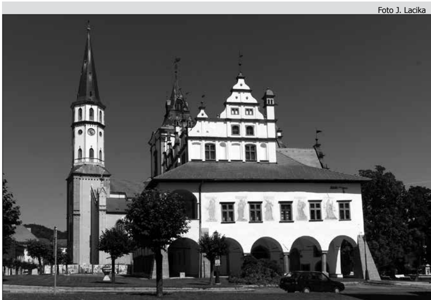
Pieskovce boli základnou surovinou pri budovaní východoslovenskej gotiky a renesancie. Komplex budov kostola sv. Jakuba, zvonice a radnice v Levoči. Všetky architektonické prvky na objektoch sú zhotovené z tejto tvárnej horniny.
