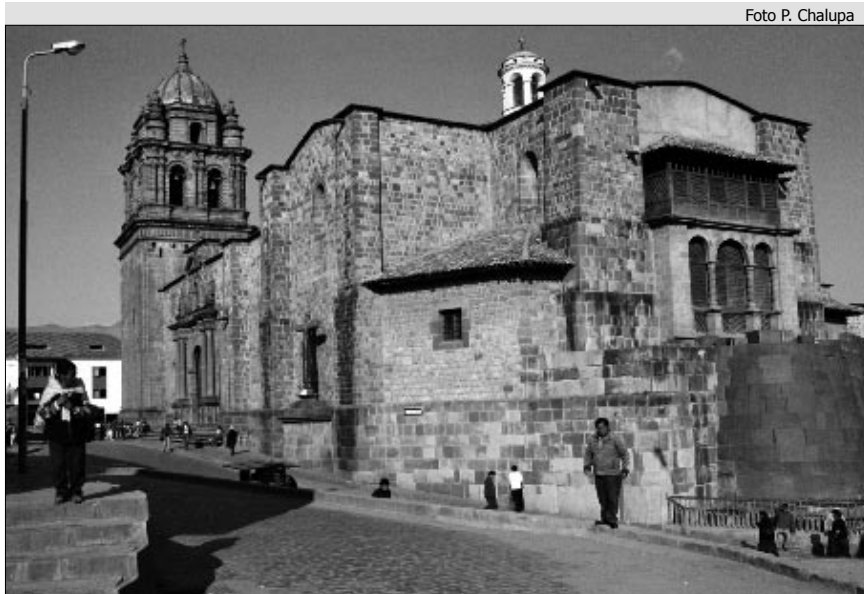
Na základech španělských chrámů jsou vidět původní incké stavby.
