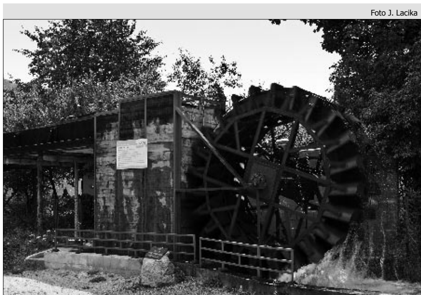
Obecná elektrárň v Necpaloch
