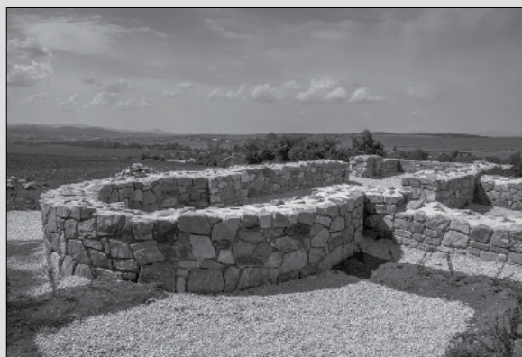
Základy stredovekého kostola nad Skačanmi
