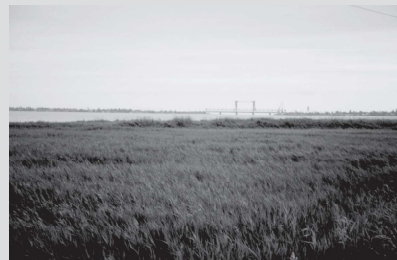
3. Liman Dnestra so zdvíhacím mostom cez prietokové hrdlo u obce Zatoka (vpravo)
